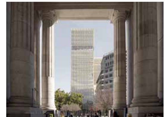
MI.C è un progetto che prevede la riqualificazione dell'ex Hotel Michelangelo e della piazza adiacente. Nell'immagine, la nuova Torre vista dalla Galleria delle Carrozze della Stazione Centrale di Milano. Credit: Park Associati
